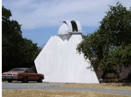
Věž a kopule Wilcoxovy sluneční observatoře. V kopuli se nachází coelostat, jehož pomocné zrcadlo je viditelné ve šterbině.
